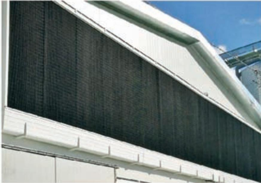
Eine Pumpe transportiert Wasser durch das System und führt es von oben über ein Sprührohr und den Deflektor zu den Pads. Dann fließt das Wasser über die netzartige Oberfläche der CoolPads.
