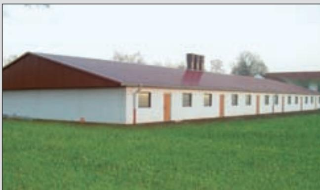
Außenwand Betonsandwich, weiß durchgefärbt
