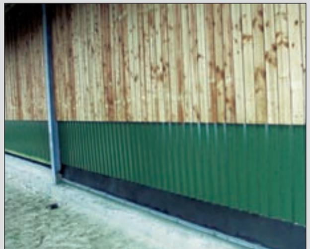
Zuluft in den Hütten mit Zuluftklappe
