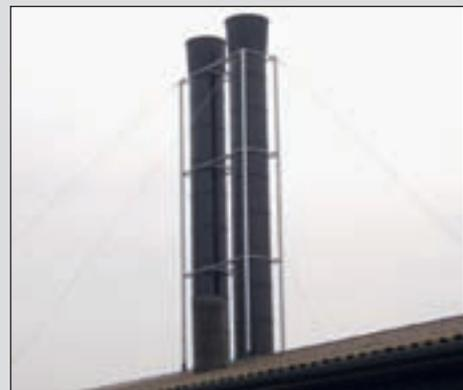
Abluftschachtverlängerung mit Abspannvorrichtung
