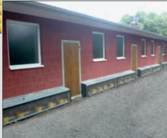
Sauenstall mit Erdwärmetauscher
