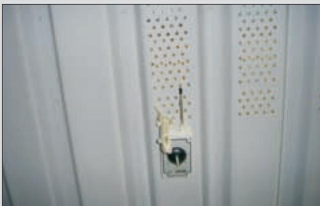
Alarmthermostat unter Diffuse-Lüftungsdecke
