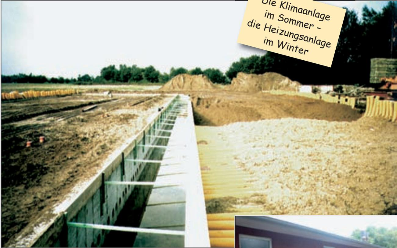
Zentralgang unterkellert als Zuluftkanal über Erdwärme
