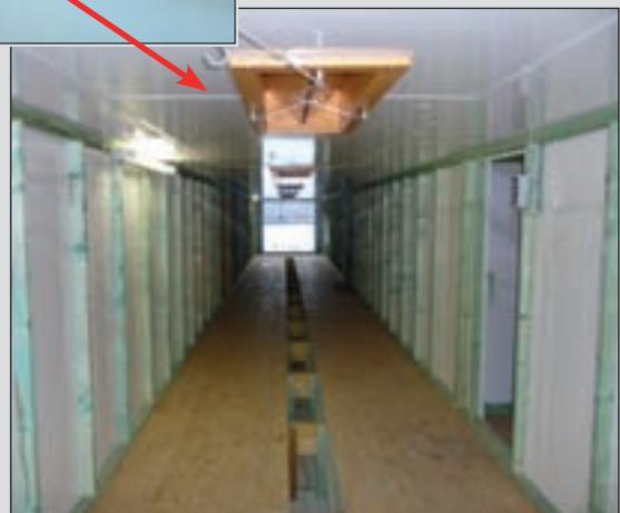
Lufttritt von dem Luftkanal in den Zentralgang
