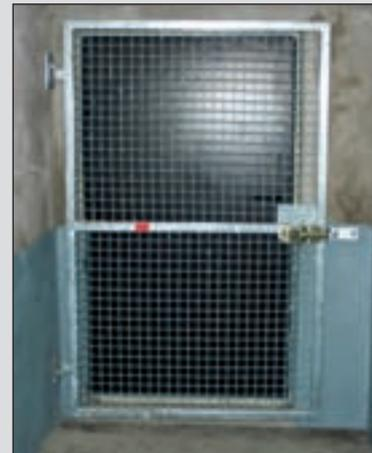
Lüftungsgitter für den Sommerbetrieb (nur von innen zu öffnen)
